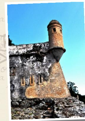
Todos os edifícios e muralhas foram construídos com alvenaria de pedras (granito extraído da própria ilha de Ratonés), e eram revestidos originalmente com reboco de cal e areia. A cal era produzida com as conchas de moluscos, abundantes na região.
